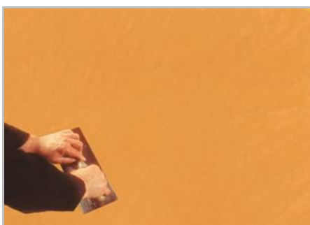
Fase 5 - Quando il prodotto comincia ad appassire procedere con la compattatura e lucidatura.
