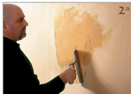
Fase 4 - Seconda mano, distribuire liberamente il prodotto con il frattazzo.
